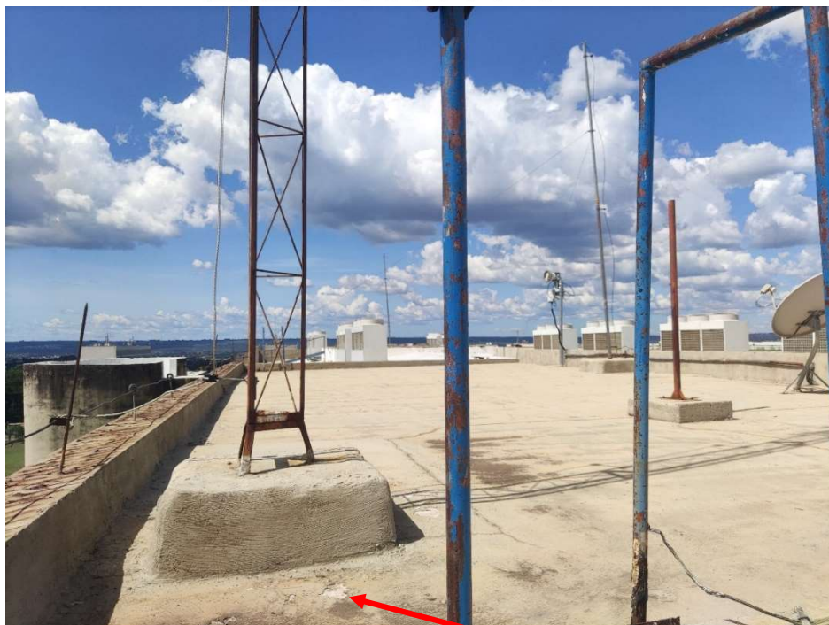
FOTO 06 – Sistema de impermeabilização em estado avançado de degradação
