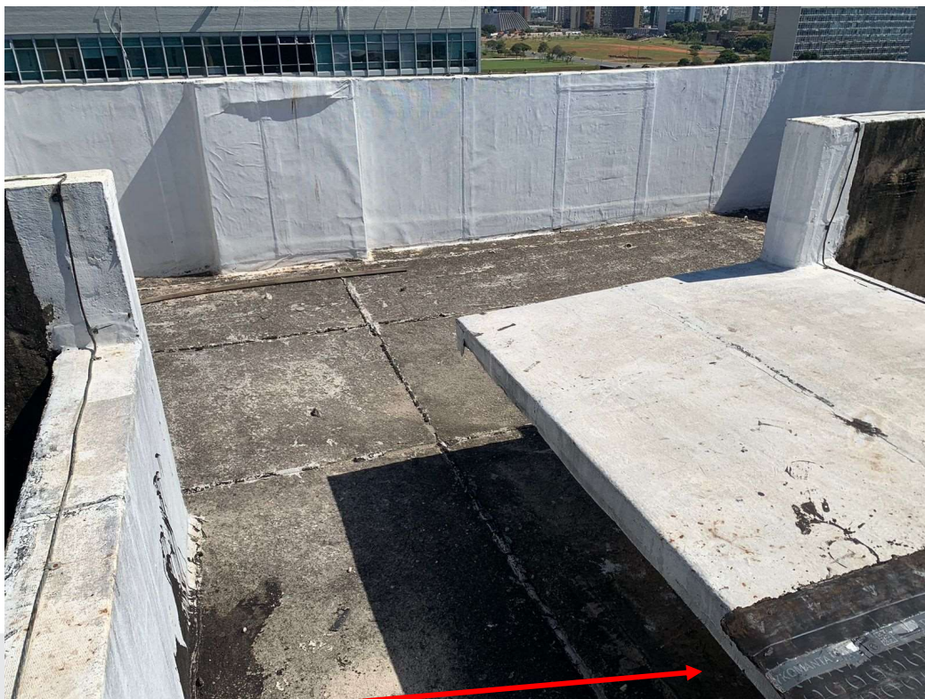
FOTO 08 – Sistema de impermeabilização em estado avançado de degradação
