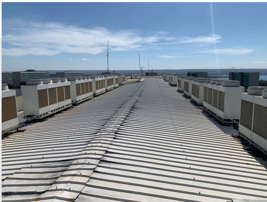
FOTO 02 – Vista geral do telhado com máquinas frigorígenas sobre o mesmo
