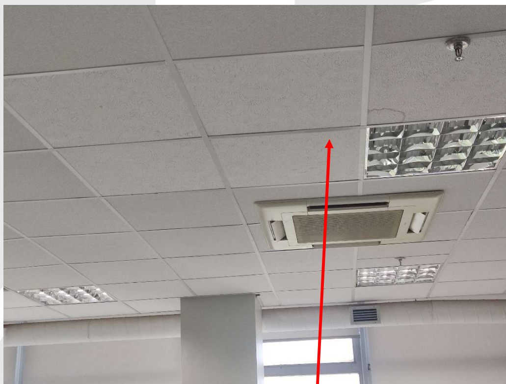
FOTO 16 – Infiltrações no forro do pavimento inferior próximo a luminárias e aparelhos de ar condicionado
