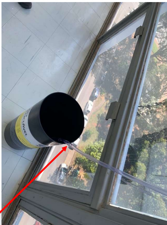
FOTO 19 – Drenos instalados para direcionar a água dos vazamentos em tambores de coleta (Solução paliativa)
