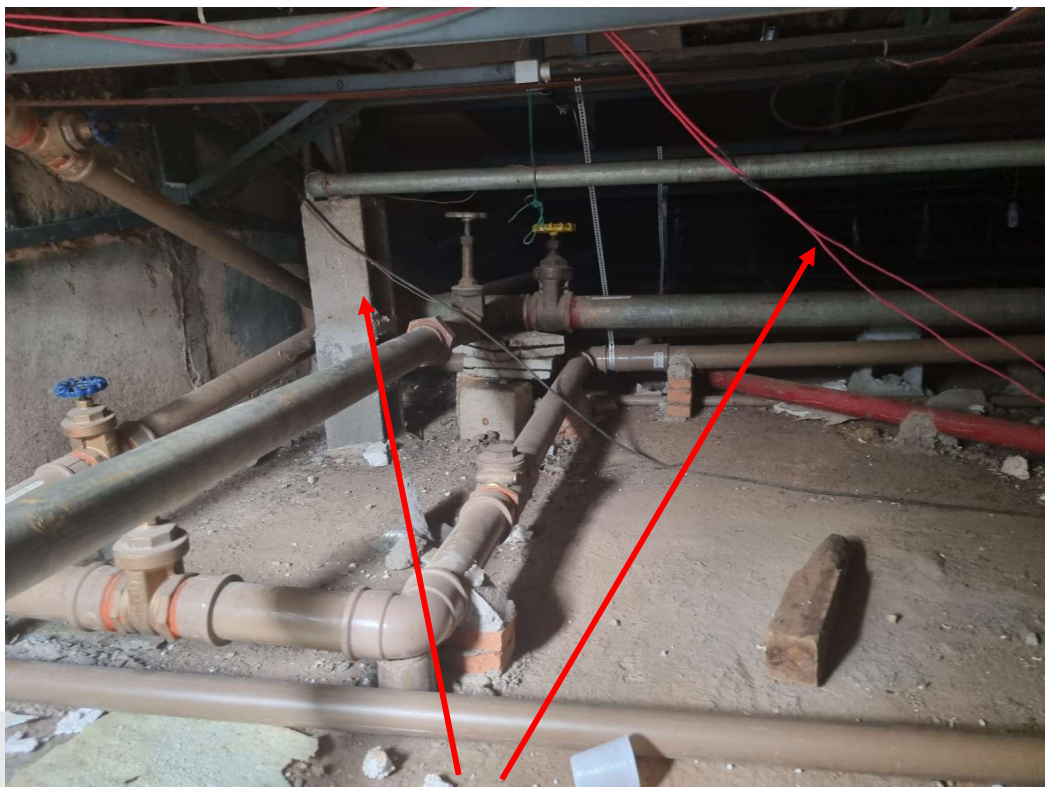
FOTO 13 – Restos de entulho e fiação exposta
